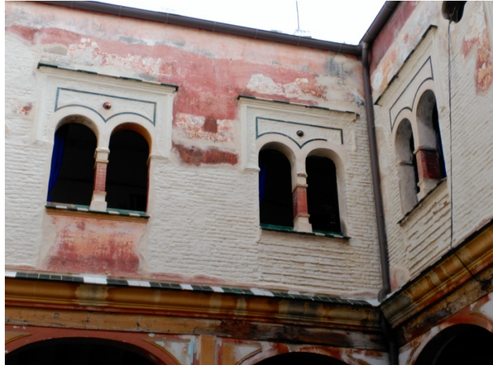
Ventanas de la planta superior.
