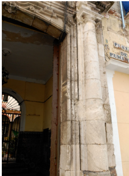
Detalle del pórtico del palacio.
